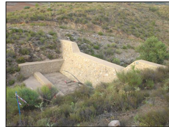
Ejemplos de hidrotecnias de corrección de cauces (diques) empeladas en la restauración hidrológico-forestal
