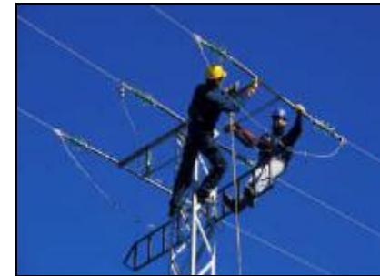
Fuente : Consj. Agricultura y Mº Ambiente Extremadura Obras de modificaciones de tendidos eléctricos peligrosos para las aves
